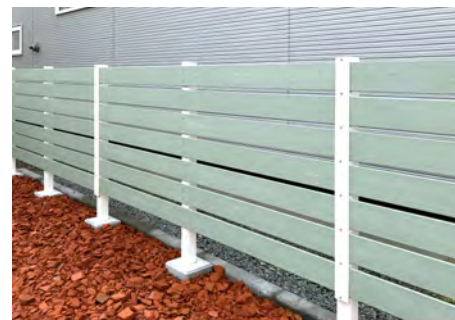
ハンプトングリーンの施工例
